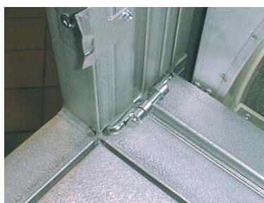
Соединение блоков изнутри 004-055
